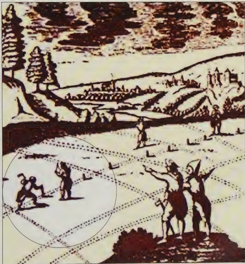
Gravure de 1700 extraite du Speculum metallugieum polissimum de B. ROSSIER. Sous la conduite d'un radiesthésiste équipé d'une baguette de sourcier, un ouvrier plante des piquets en vue d'une construction.
